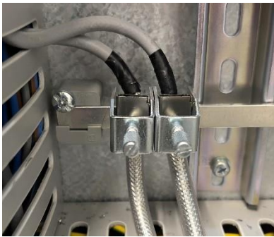
Abbildung 6: Kabelanschlussklemmen für Schaltschrankmontage
