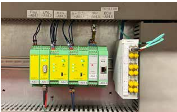
Funktionsmodule des Universal-Drehgeber-Systems U-ONE im Schalt- schrank.
