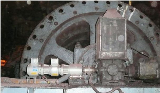
Stahlerzeugung / Skip Car: Lagerbock mit inkrementalem Drehgeber FG 40 und Absolutwert-Drehgeber AMS (SSI-Schnittstelle) Steel making / Skip car: bearing block with incremental encoder FG 40 and absolute encoder AMS (SSI interface)
