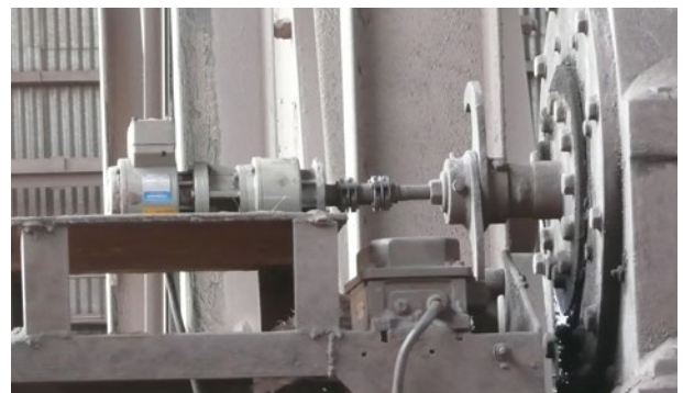
Materialtransport / Waggonkipper: Lagerbock mit angebautes Absolutwert-Drehgeber AMN (DeviceNet-Schnittstelle) Material handling / Wagon tippler: bearing block with attached absolute encoder AMN (DeviceNet interface)
