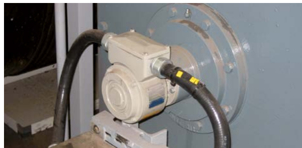
Инкрементальный энкодер FG(H) 40 L Incremental encoder FG(H) 40 L
