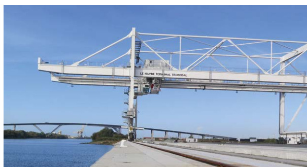
Construcción de MAG en el mecanismo de elevación de grúa de una grúa RMG Installation of the MAG at the crane hoist of a RMG crane
