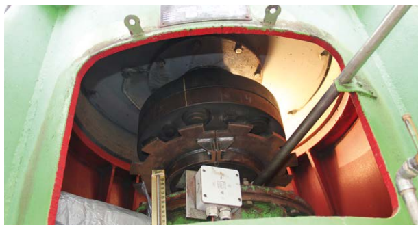
Reacondicionamiento exigente debido a falta de espacio Demanding retrofit due to narrow spaces
