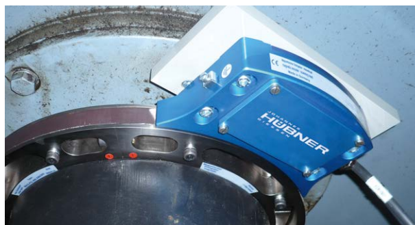
Realización con rueda magnética dividida sin desmontaje de instalación Realization with split pulse wheel without dismantling of installation
