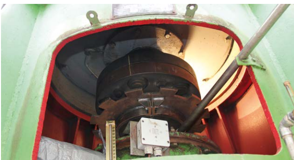
由于空间狭窄，需要改造 Demanding retrofit due to narrow spaces
