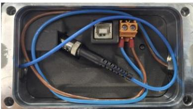
Abbildung: LWL-Kabel und Versorgungskabel im Klemmkasten des FGJ 2
