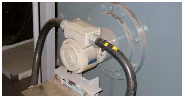
Inkrementaler Drehgeber FG(H) 40 L Incremental encoder FG(H) 40 L
