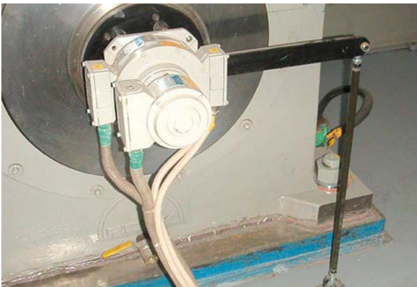
Anbau von FGH 6 mit EGS 4 über Flansch-Adapterwelle und Drehmomentstütze, mit Fußplatte auf Betonboden.
