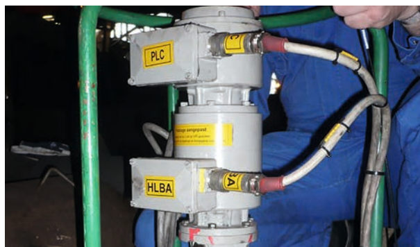
Walzwerk / Anstellungen: Absolutwert-Drehgeber AMSI (SSI-Schnittstelle und Inkrementalausgang) und angebautes Absolutwert-Drehgeber AMS (SSI-Schnittstelle)
